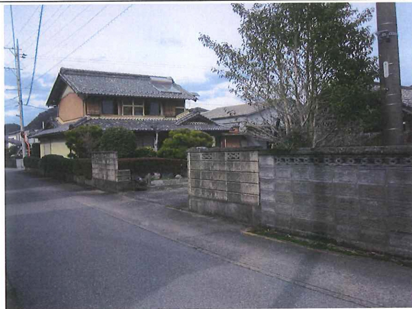
撮影項目 外観全景 南西から北東を見る
