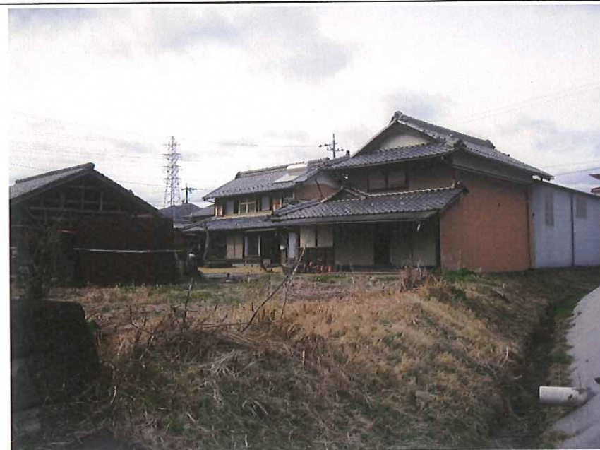
撮影項目 外観全景 南東から北西を見る
