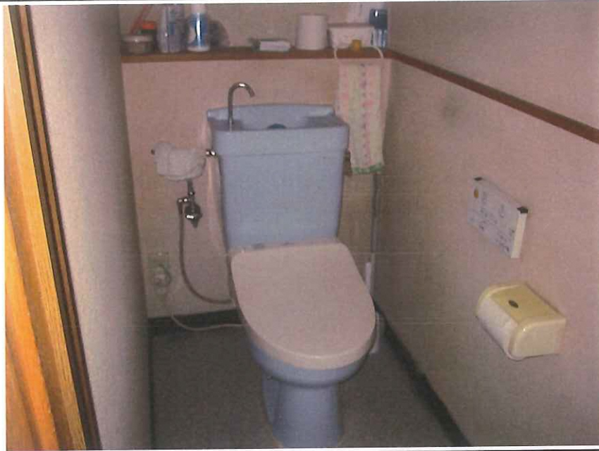
撮影項目 内観 1階女性便所
