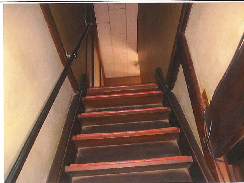
撮影項目 内観 1階階段 北から南を見る
