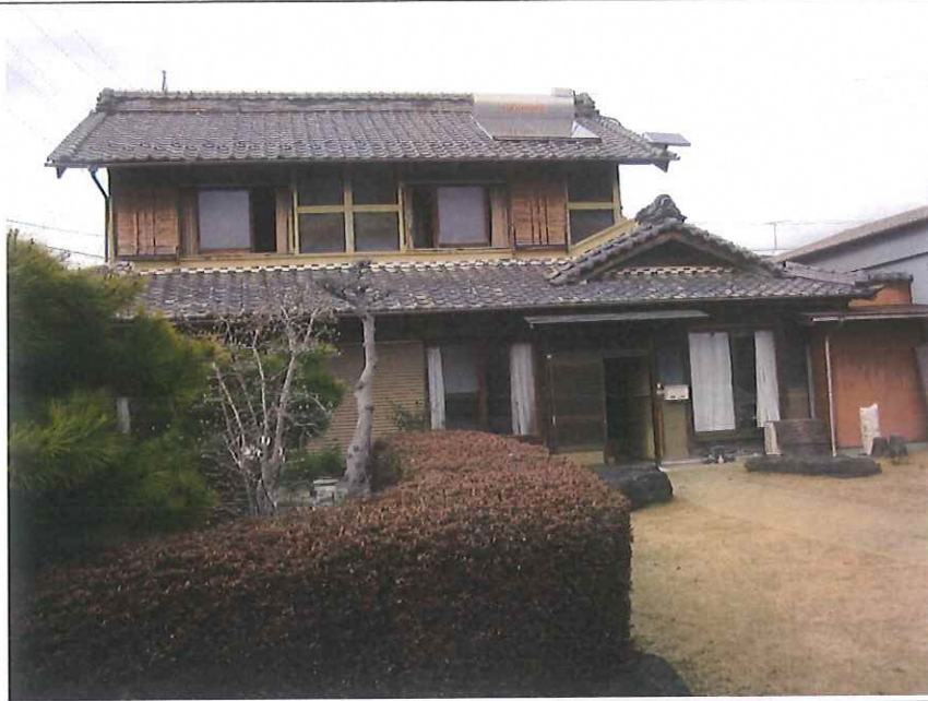
撮影項目 外観全景 南から北を見る
