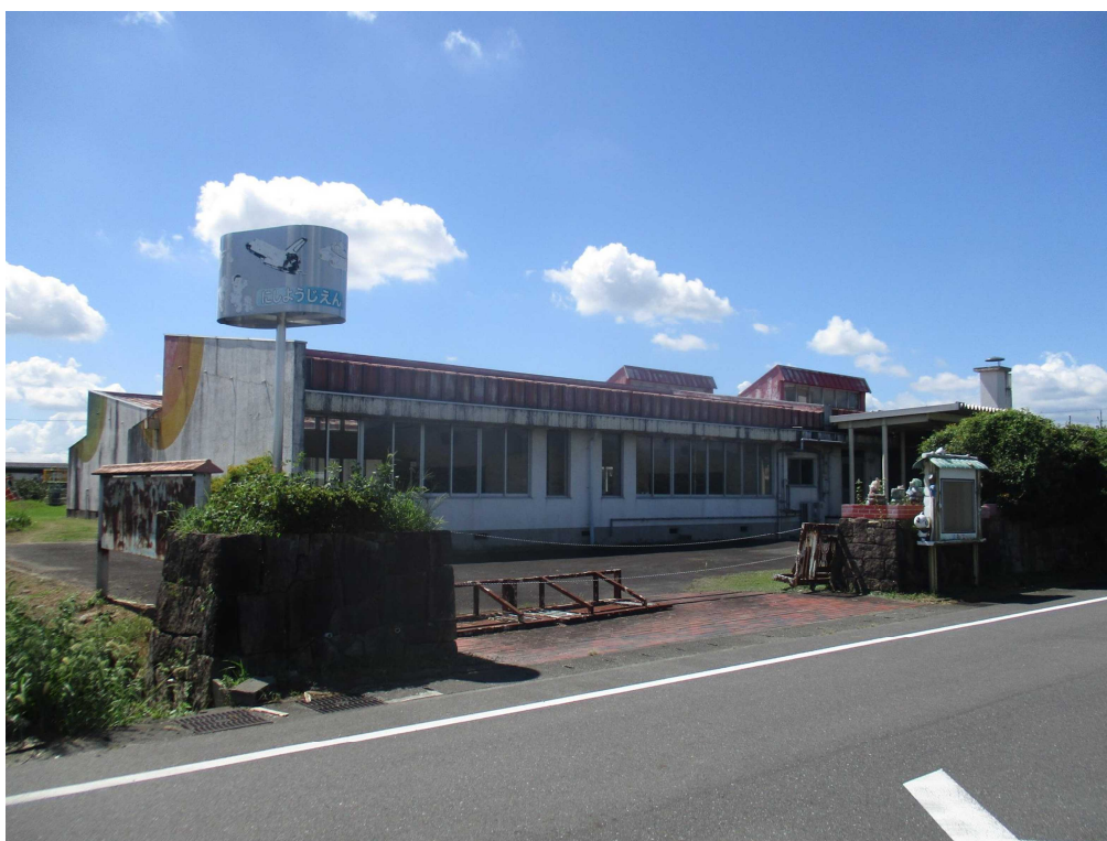
敷地北東側から南西向きに撮影（令和6年9月11日撮影）
