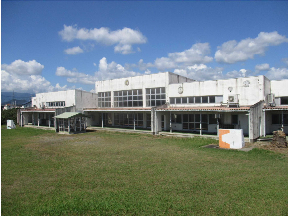
敷地南東側から北西向きに撮影（令和6年9月11日撮影）
