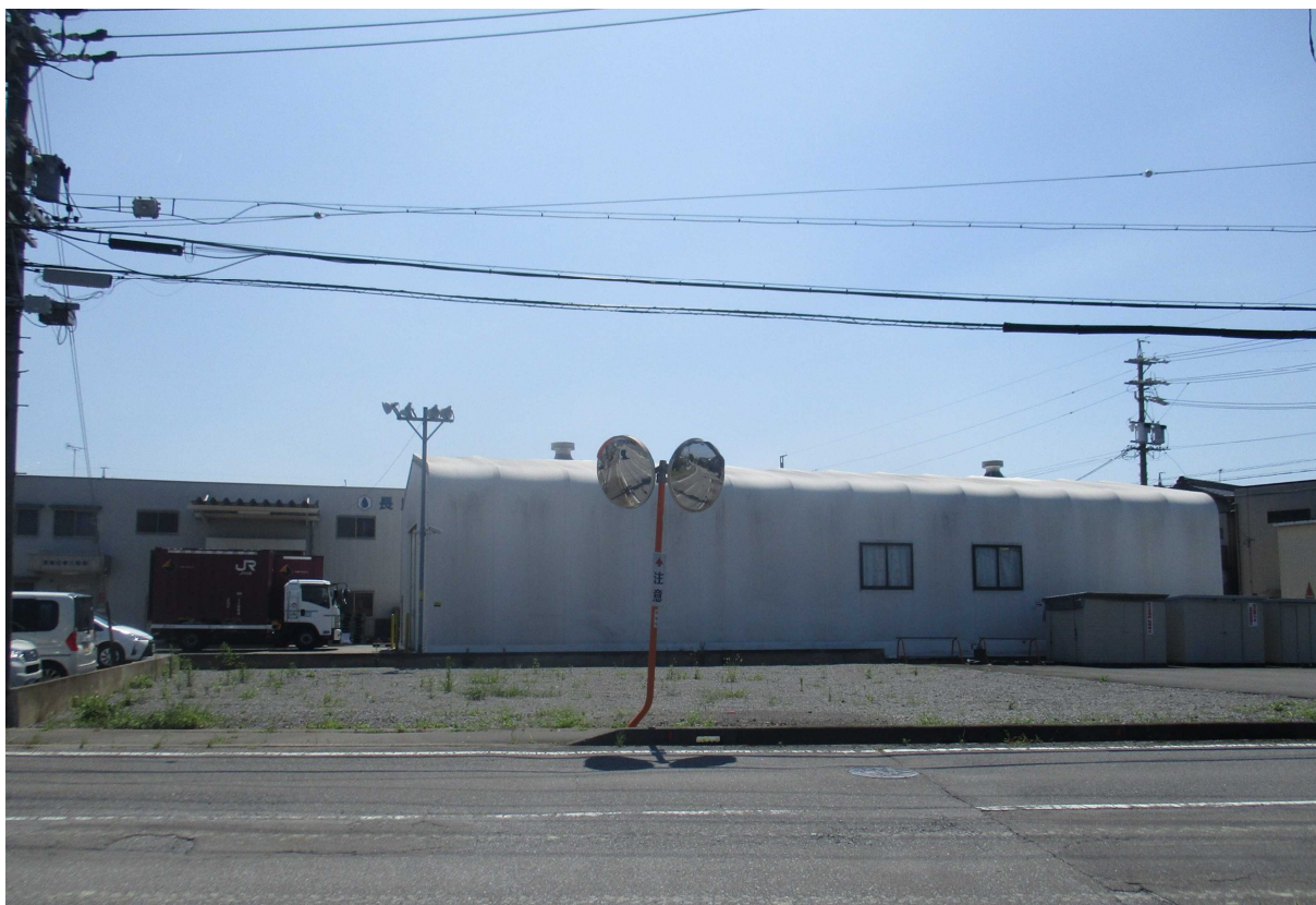
敷地西側から東向きに撮影（令和8年7月9日撮影）
