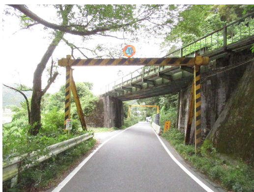
全景（起点側）2-3133-M-03
