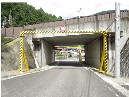
全景（起点側）2-3142-M-11
