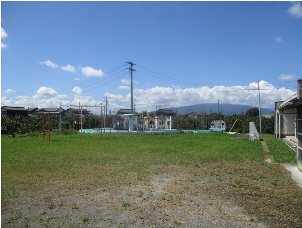
東側から西向きに撮影（令和6年9月11日撮影）
