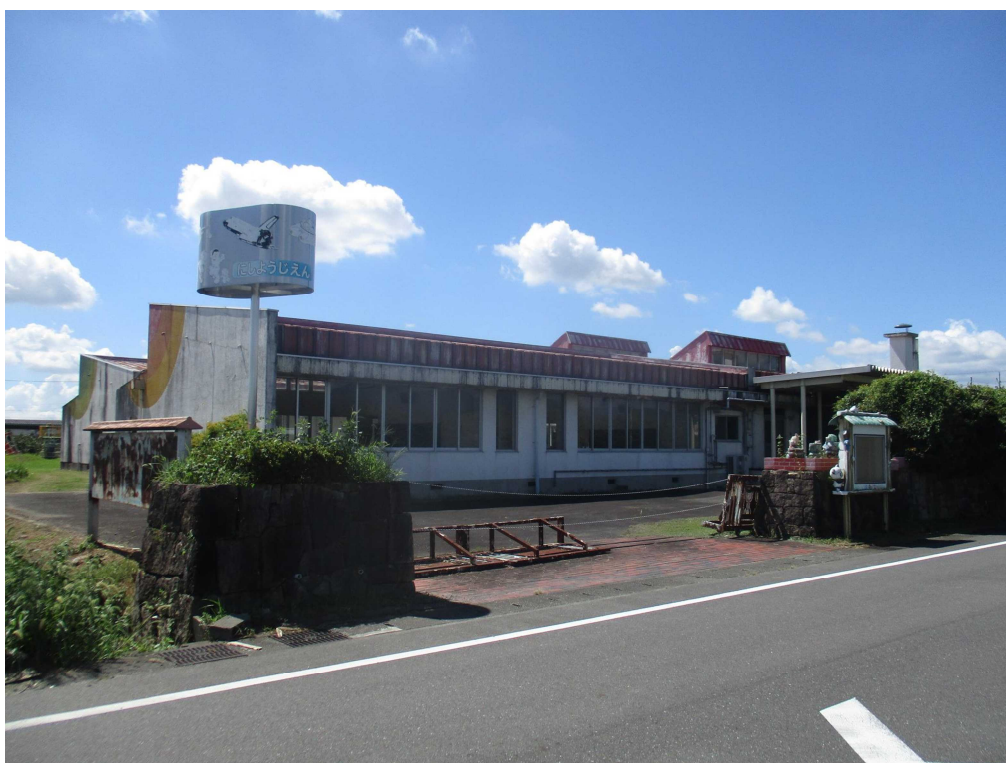
敷地北東側から南西向きに撮影（令和6年9月11日撮影）
