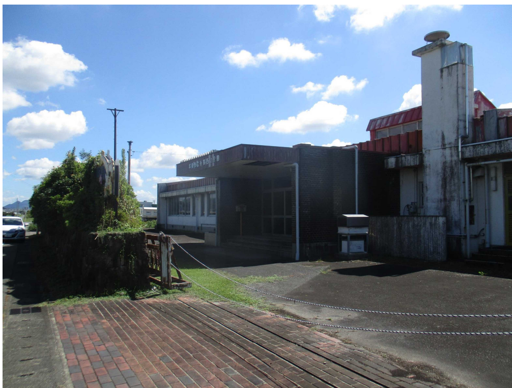
敷地北西側から南東向きに撮影（令和6年9月11日撮影）
