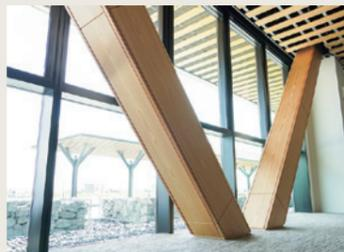
耐震ブレースを設置することで、建築物の耐力と粘り強さを向上。震度6～7クラスの揺れにも対応します。
