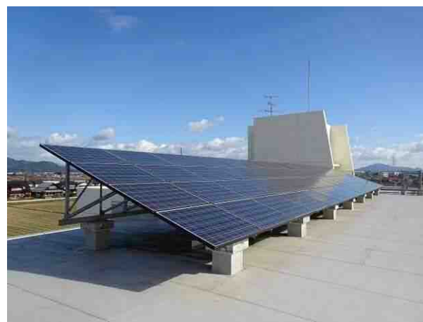
土貴野（ときの）小学校の太陽光パネル設置状況
