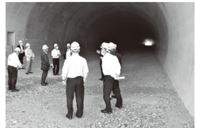
▲(仮称)船来山トンネルを視察する委員
