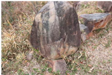
石材の劣化状況 赤彩古墳19号墳
