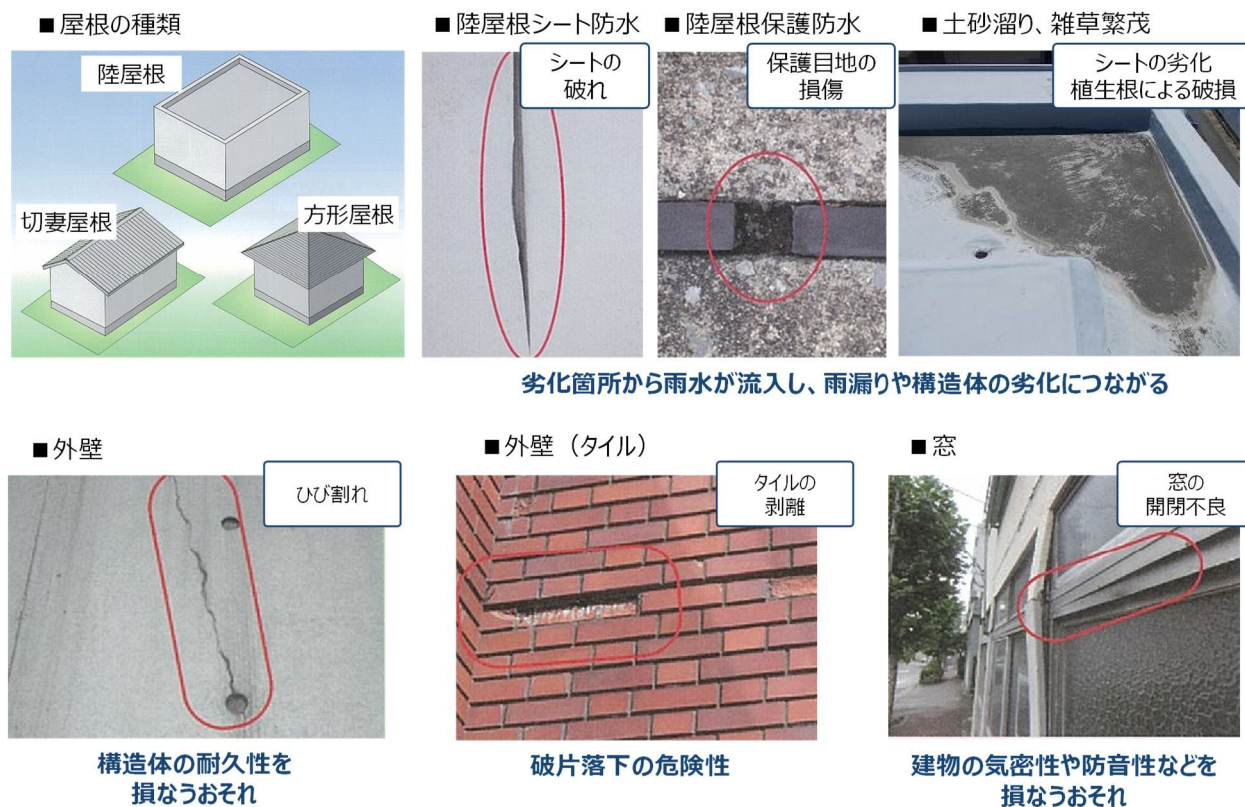
図 3.8 外壁の損傷事例
