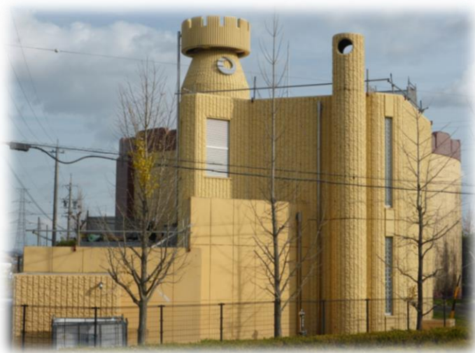
真正第2浄水場
