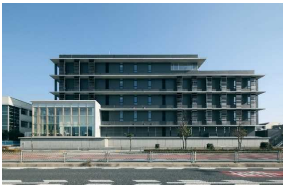
メンテナンスバルコニーを設けた庁舎の事例（左：半田市庁舎 右：習志野市庁舎）
