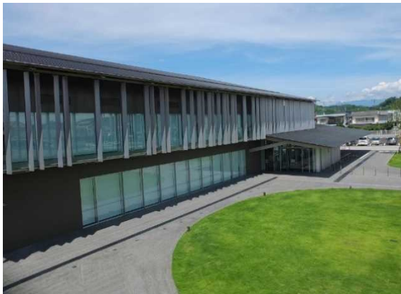
ルーバーを設置した外観の事例（富岡市庁舎）
