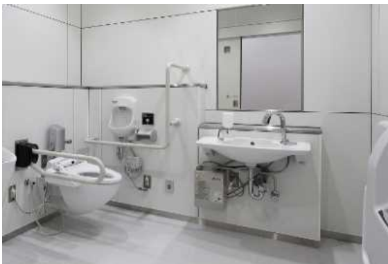
多目的トイレの事例（北本市庁舎）
