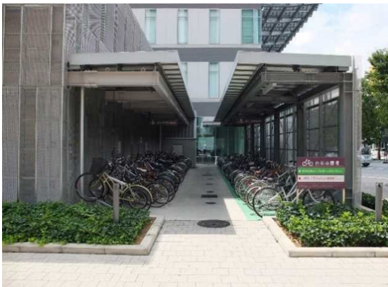
屋根付き駐輪場の事例（甲府市庁舎）
