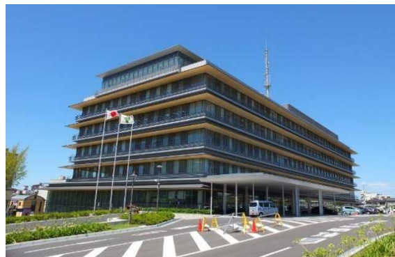
メンテナンスバルコニーを設けた庁舎の事例（左：半田市庁舎 右：習志野市庁舎）
