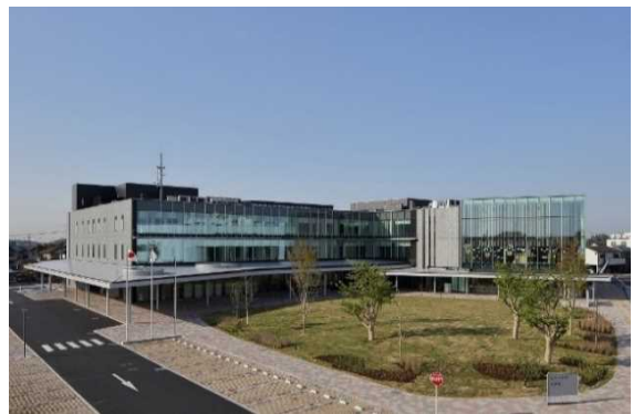
防災広場の事例（北本市庁舎）
