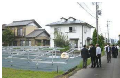
▲太陽光パネル設置場所を視察する委員
