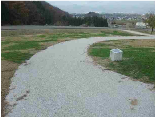
脱色アスファルト舗装の園路
