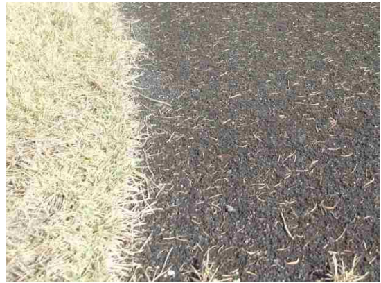
木質系舗装の園路は、やわらかく歩きやすい。
