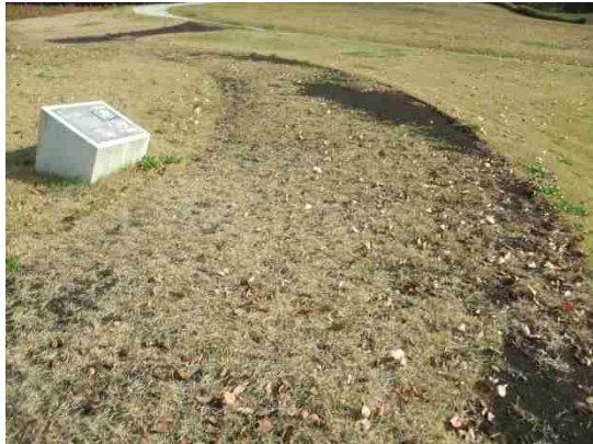
木質系舗装の園路は、周囲のシバが侵入しやすいという問題点もある。
