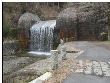
鷺巣第一砂防堰堤
