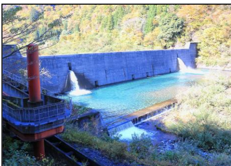
大河原第一砂防堰堤
