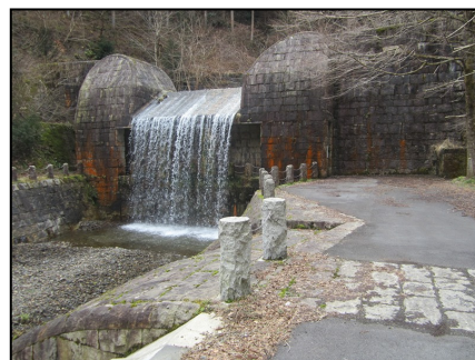
鷺巣第一砂防堰堤
