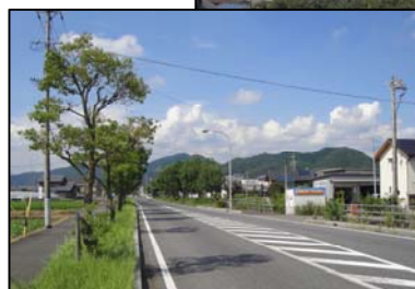
緑化された国道 157 号
