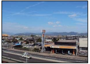
幹線道路沿道の建築物
