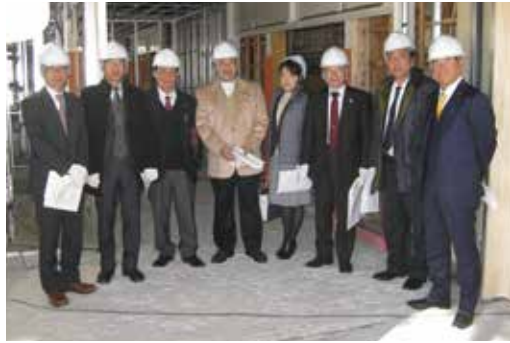
弾正小学校体育館改修工事を視察する委員
