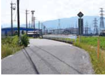
▲犀川橋の現場
