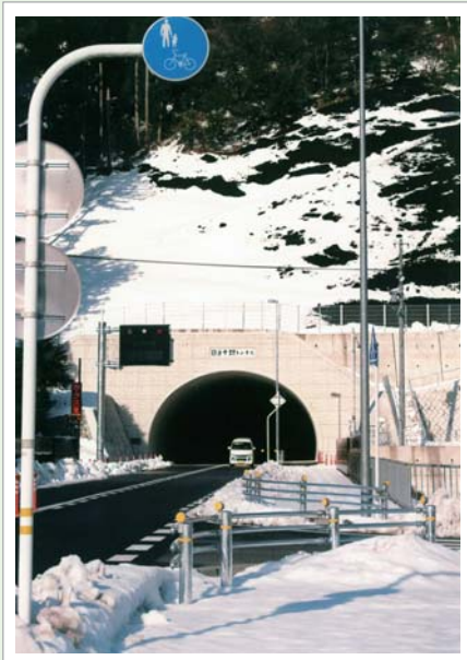
▲日当平野トンネル(12月6日 竣工)
