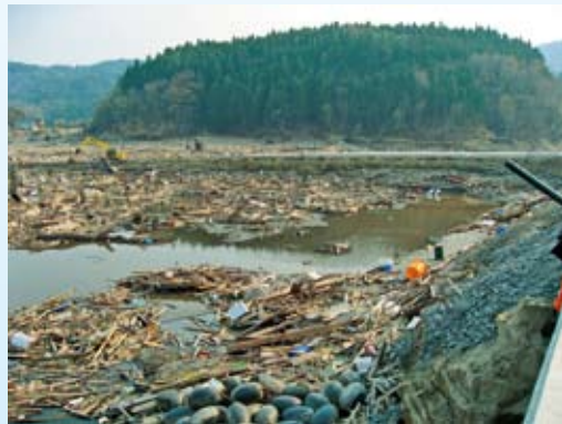
▲地盤沈下した街
