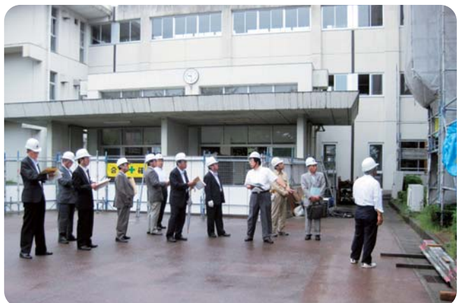
▲真正中学校校舎耐震工事現場視察
