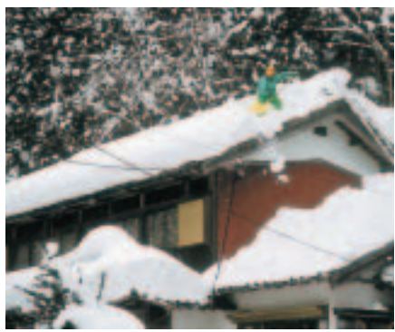
▲屋根雪下ろし
