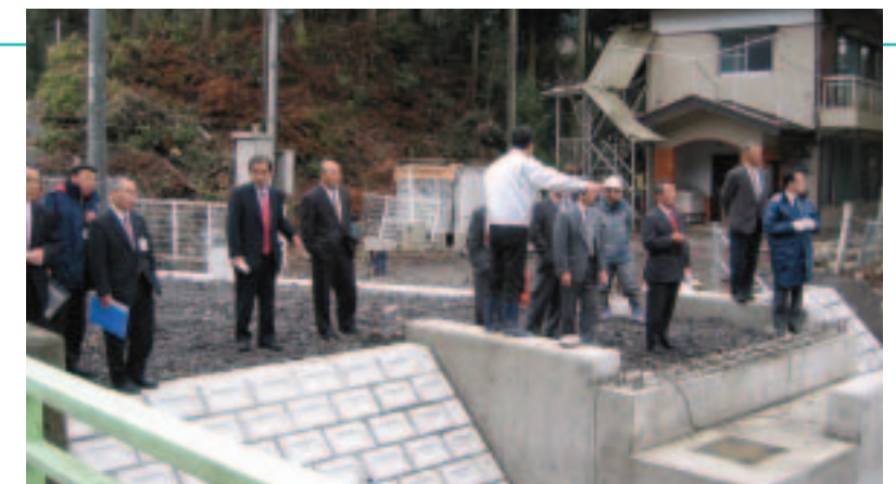
▲桜橋歩道橋工事現場を視察する委員
