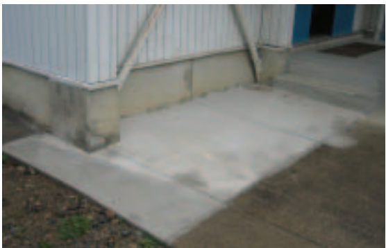
▲耐震補強をした席田小学校体育館
