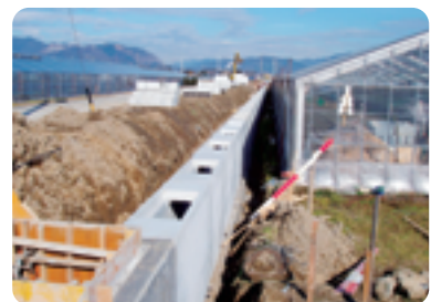
西部連絡道路工事現場
