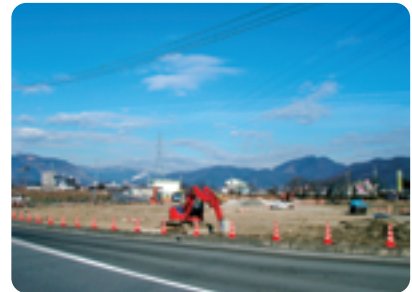
糸貫川多目的広場工事現場
