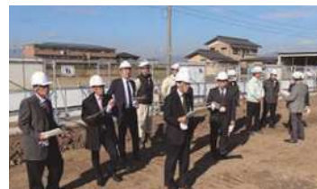
▲真桑幼稚園改築工事現場を視察する委員
