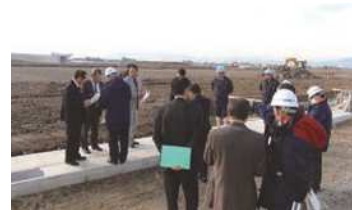
▲(仮称)PA周辺公園工事現場を視察する委員
