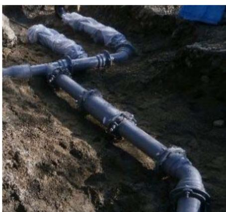
耐震管（ダクタイル鋳鉄管GX形）
