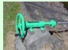
ゲート、バルブの更新
