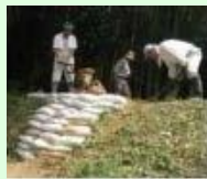
漏水箇所の補修
