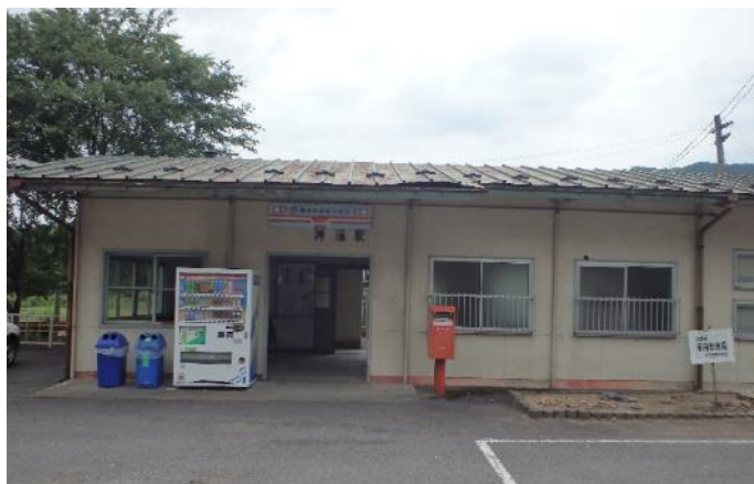
清掃後の神海駅正面の様子
