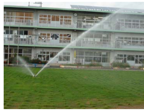
散水の様子(スプリンクラー設置数:10基)
